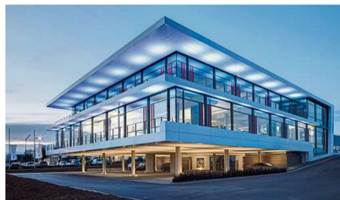
Die Aussenansicht des Planungsbüros Schnepf auf dem Nagolder Wolfsberg Foto: Wilhelmy
